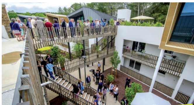
Un ensemble de coursives et passerelles permet de desservir chaque appartement et facilite les rencontres.
