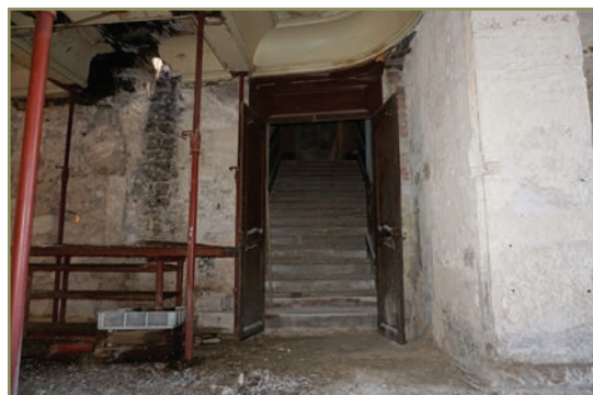
L'escalier principal donnant accès au premier étage du château.
