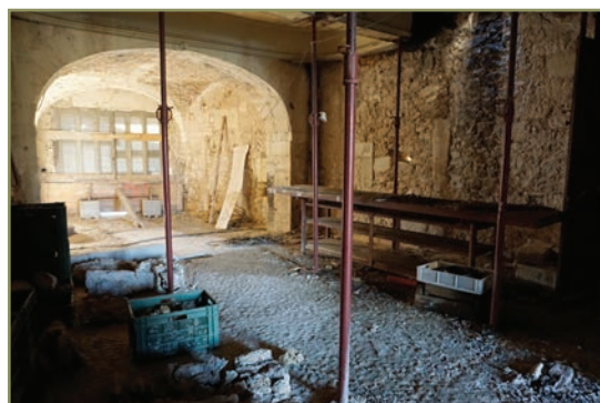
Des travaux de consolidation ont été assurés pour éviter toute dégradation du bâti.
