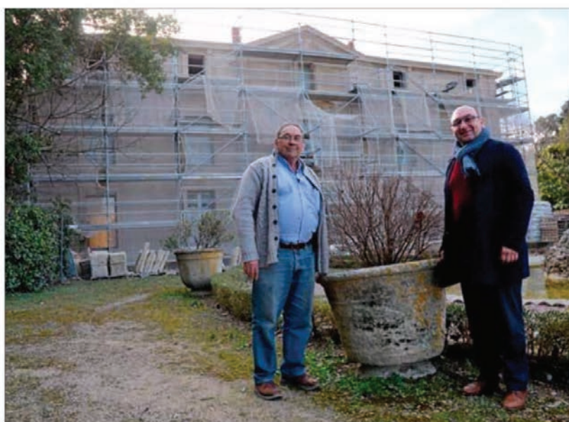
■ Le maire Renaud Calvat et Olivier de Labrusse lors d'une visite de chantier.
