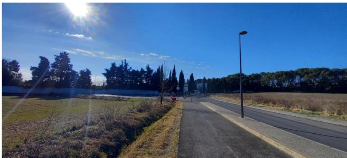
Vue Nord-Est : la rue d'Occitanie, le parking et le bâtiment de la Passerelle en second plan
